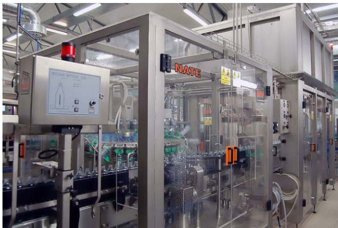
Füllvorrichtung mit Überdeckung - PEPSICO, Betrieb Toma Teplice nad Metují, Tschechische Republik
